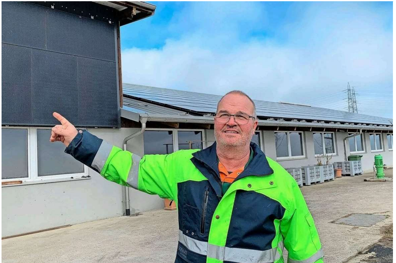
Eine PV-Anlage mit 350 kWp Leistung hat Thomas Estermann aus Hildisrieden auf dem Dach und der Fassade der Schweinescheune installiert. Vom produzierten Solarstrom kann er aber nur 20 Prozent selber nutzen. (Bild: Josef Scherer)
