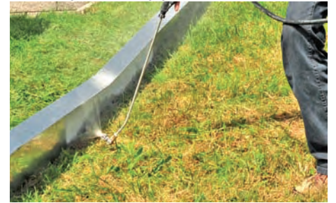
Auftragen des FS nonstick auf die Außenseite des Zaunes.
