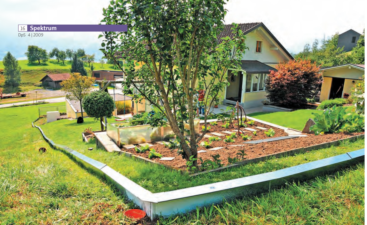
Einzäunung eines Hauses gegen den Tausendfüßler-Befall.
