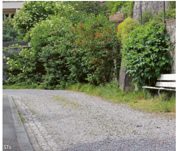
Unversiegelter Weg mit asphaltiertem Trottoir und gepflasterter Regenabflussrinne (Länggasse)
