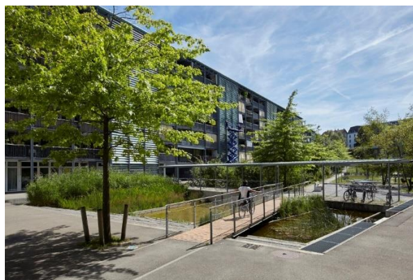
Abb. 2 Regenwasserrückhaltebecken im Regina-Kägi-Hof in Oerlikon (ZH) © Reto Schlatter, ABZ Zürich
