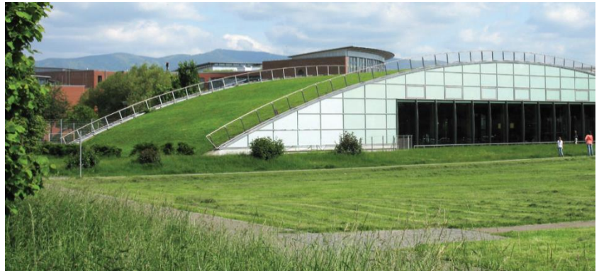
Abb. 2 Gründach der Sporthalle der Clara-Grunwald-Schule in Rieselfeld © Stadt Freiburg im Breisgau
