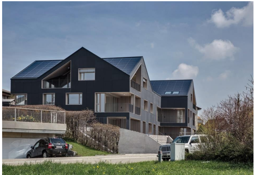
Abb. 2 Erstes energieautarkes Mehrfamilienhaus der Welt, ein Projekt der Umweltarena Schweiz © Umweltarena
