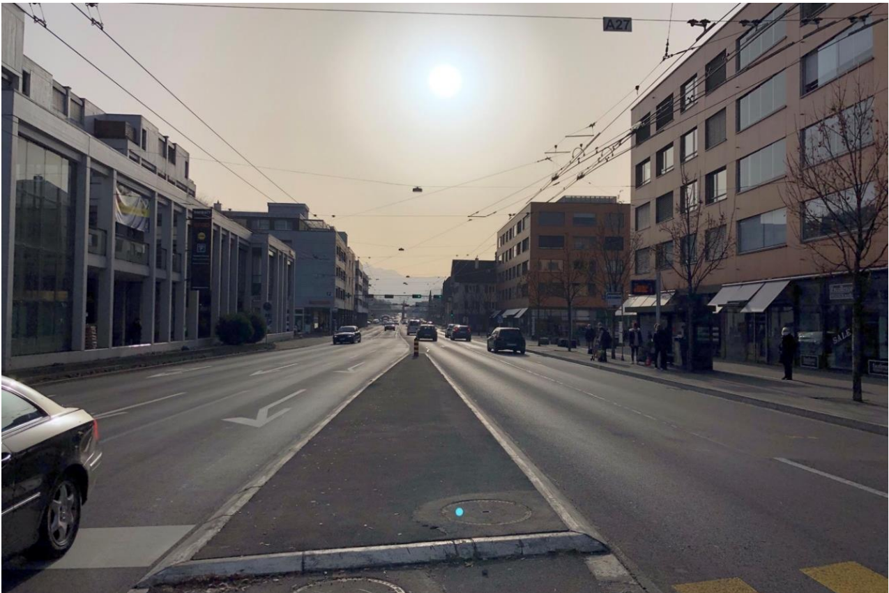
Abbildung 42 Die Kreuzung Zentralstrasse /Bahnhofstrasse in der gleissenden Sonne (eigenes Foto, Feb. 2021)
