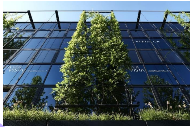
Bodengebundene Fassadenbegrünung mit zusätzlicher Kletterhilfe in Pfäffikon (ZH) © Jakob Rope Systems
