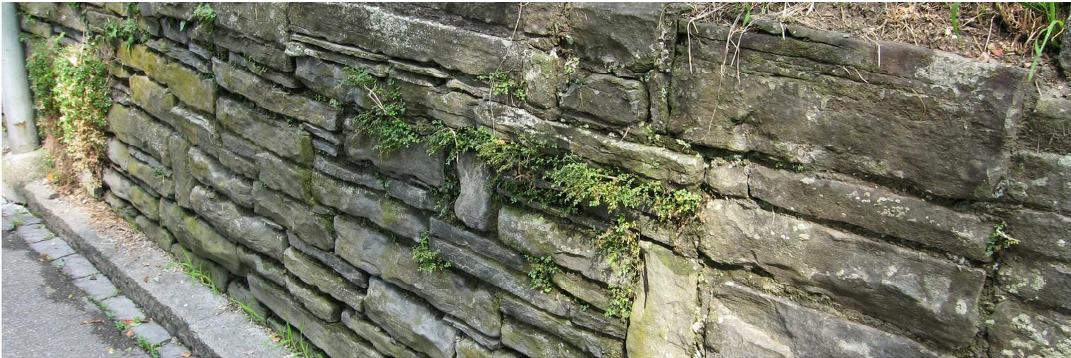
Für Trockenmauern eignen sich vor allem plattige oder gebrochene Steine, da diese viel leichter aufzuschichten sind als runde Steine. Dies ist deshalb wichtig, weil die Mauer, wie der Name sagt, „trocken aufgeschichtet“ wird, d.h. ohne (feuchten) Mörtel. Geeignet sind z.B. alte Gartenplatten und Randsteine, mehr oder weniger intakte Abbruchsteine verschiedener Grösse, Bruchsteine, plattige, behauene oder bruchrohe Steine aus einem Steinbruch.
