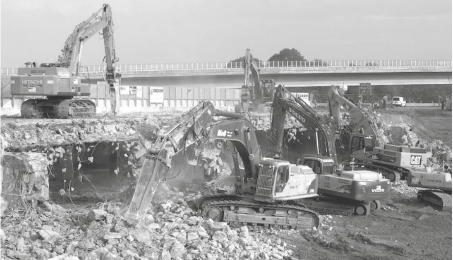
Abb. 36: Rückbau Spannbetonbrücke, Moß Abbruch-Erdbau-Recycling GmbH & Co. KG
