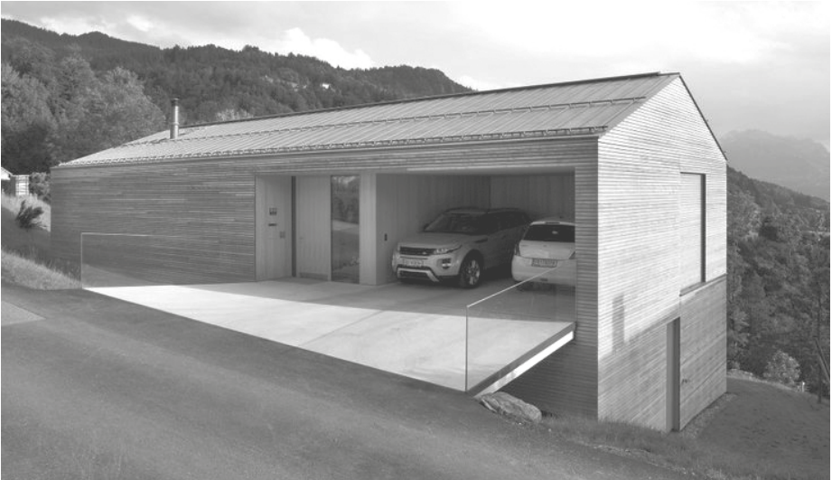
Abb. 39: Haus B, Dafins, Dietrich / Untertrifaller Architekten
