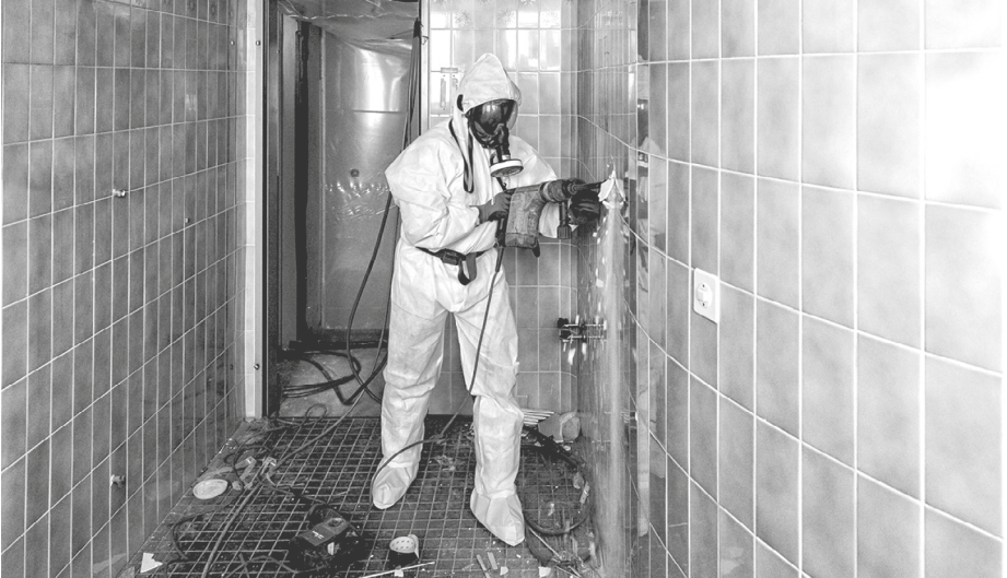
Abb. 19: Asbestsanierung, Anliker
