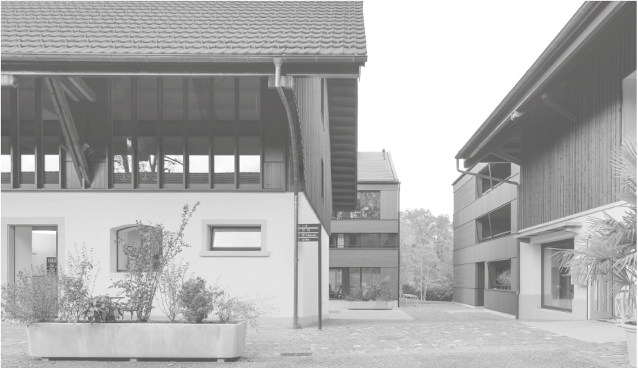
Abb. 3: Alt- und Neubauten in altem Dorfteil Hammergut, Cham, EM2N Architekten
