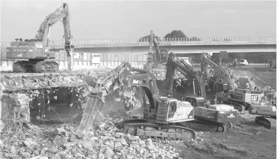
Abb. 34: Rückbau Spannbetonbrücke, Moß Abbruch-Erdbau-Recycling GmbH & Co. KG
