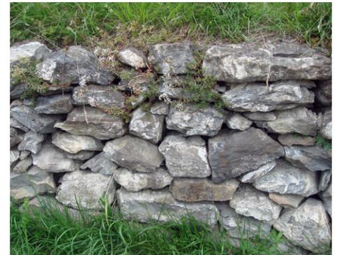
Schichten Sie eine Trockenmauer mit verschiedenen grossen Ritzen und Spalten auf.
